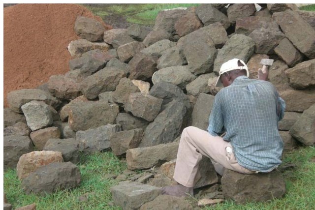
Manuell hugging byggstein som senere gjerne påføres forblending av pigmentert puss.
